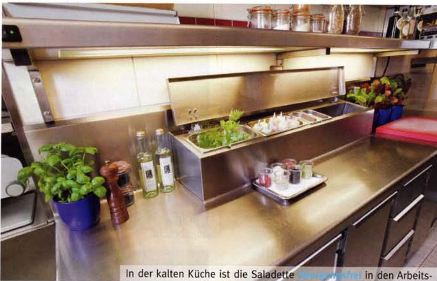
In der kalten Küche ist die Saladette eingeschweiß in den Arbeits-tisch eingeschweiß. Dieser wird optimal beleuchtet.
