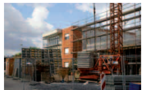
Zu klein ist das Verwaltungsgebäude in Hamm geworden. Ein zweites wird daher gerade gebaut. Foto: Reinhardt
